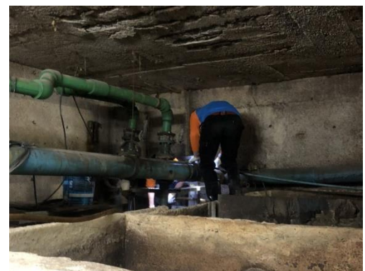
สับตะกอนและไขมันระบบบำบัดน้ำเสีย
