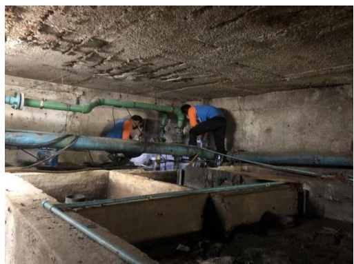
สับตะกอนและไขมันระบบบำบัดน้ำเสีย
